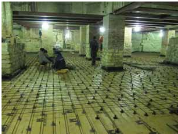
I lavori di impermeabilizzazione all'interno della Chiesa
