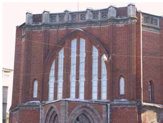
La facciata con le nuove finestre
