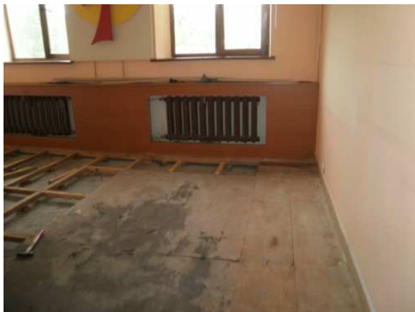
Si smantella la struttura in legno
