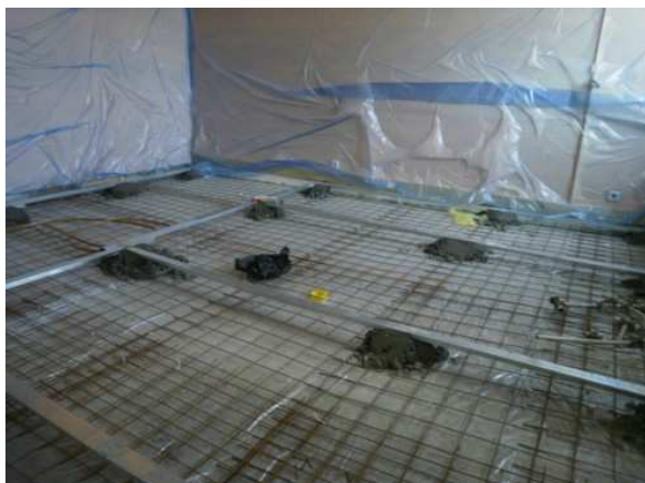
La nuova armatura
