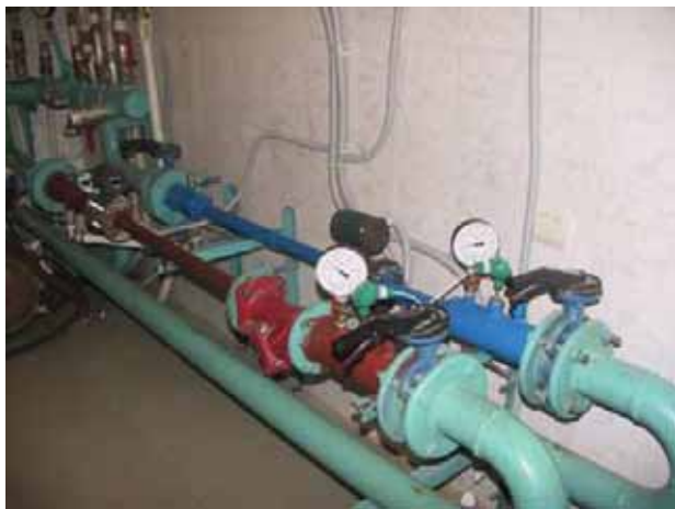
I lavori sulla linea del riscaldamento
