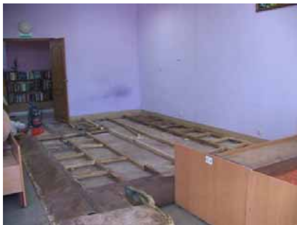
Si eseguono i lavori sul pavimento di una stanza
