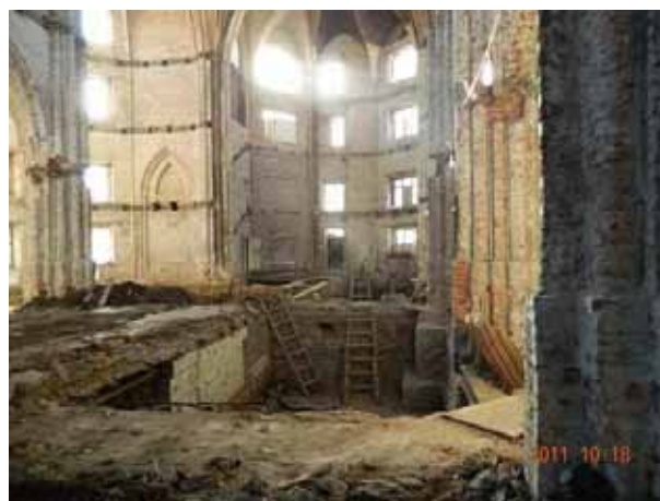
Lavori di scavo
